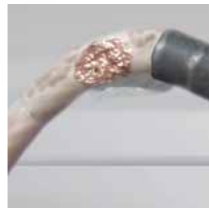
Prioridad para la seguridad del servicio: Cambio de aislamientos deteriorados
