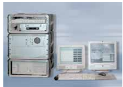
Transmisión directa durante el recorrido. En las pantallas del tren de medición aparecen las imágenes en directo: Estado y comportamiento del hilo de contacto, presión de contacto, etc.
